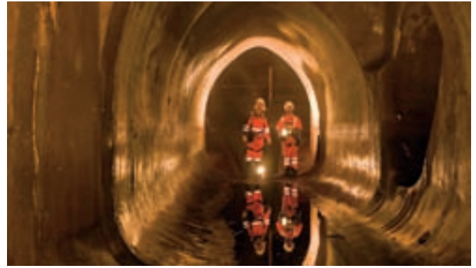
Abb. 5: Inspektion im Kanalnetz
